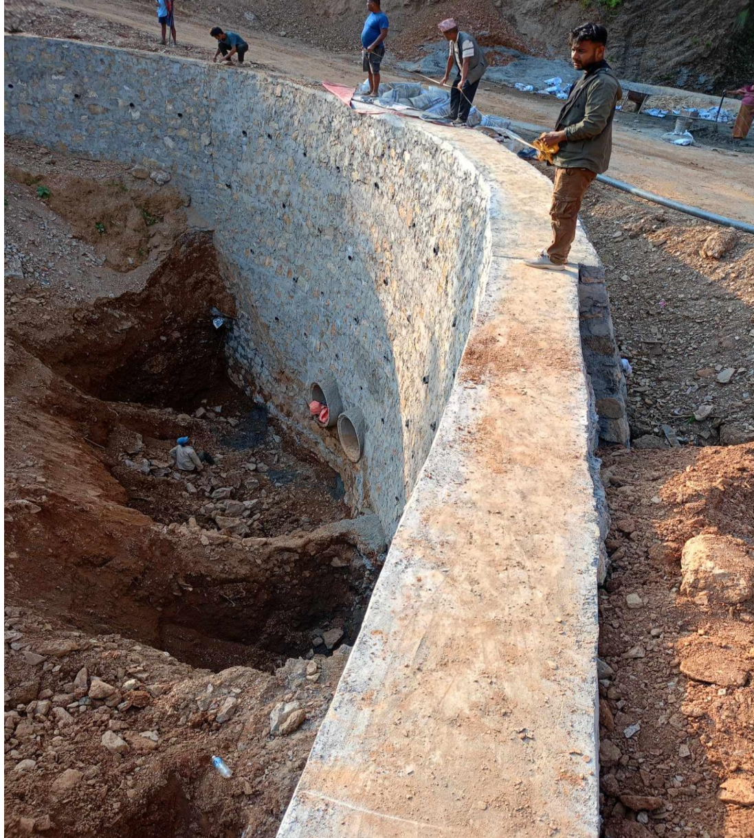
सालिग्राम कोरिडोर सडक (निर्माणाधिन)
