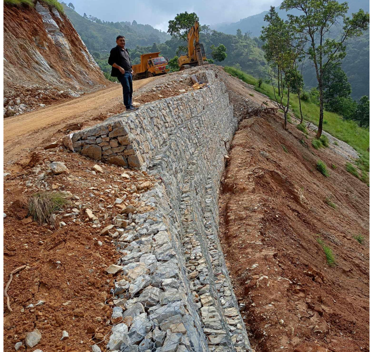
रत्ने सुन्तलाबारी बिरुवा सडक (निर्माणाधिन)
